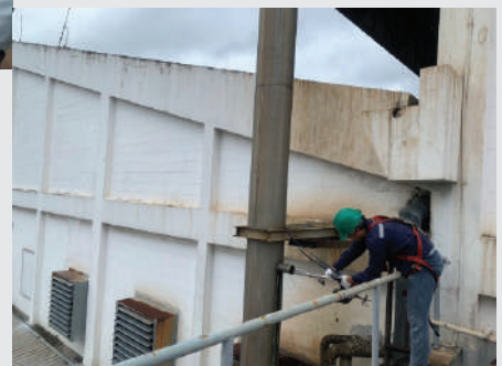
การตรวจปล่องระบายอากาศ ของ Boiler
