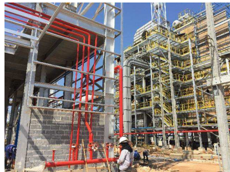
งานติดตั้งระบบดับเพลิง (Fire Protection and Detection System)
