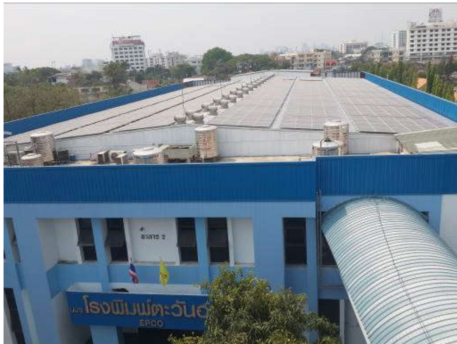
ภาพโครงการผลิตไฟฟ้าพลังงานแสงอาทิตย์ประเภท Solar Rooftop
