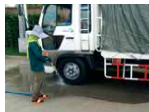
ทำความสะอาดล้อรถก่อนออกจากโครงการ เพื่อควบคุมไม่ให้ฝุ่นละอองฟุ้งไปนอกพื้นที่ก่อสร้างงาน
