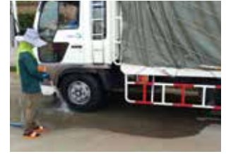
ทำความสะอาดล้อรถก่อนออกจากโครงการเพื่อควบคุมไม่ให้ฝุ่นละอองฟุ้งไปนอกพื้นที่ก่อสร้าง
