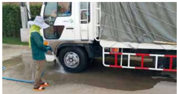
ทำความสะอาดล้อรถก่อนออกจากโครงการ เพื่อควบคุมไม่ให้ฝุ่นละอองฟุ้งไปนอกพื้นที่ก่อสร้าง
