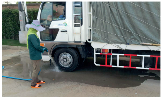
ทำความสะอาดล้อรถก่อนออกจากโครงการ เพื่อควบคุมไม่ให้ฝุ่นละอองฟุ้งไปนอกพื้นที่ก่อสร้าง
