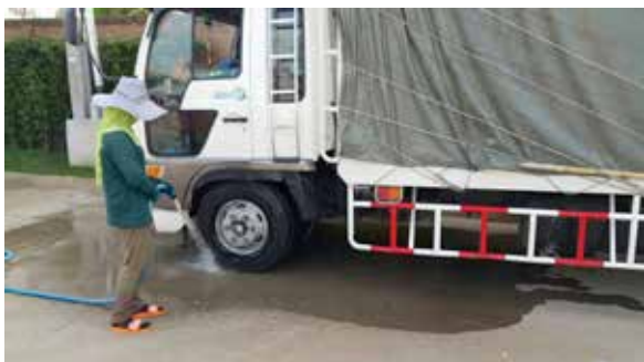
ทำความสะอาดล้อรถก่อนออกจากโครงการ เพื่อควบคุมไม่ให้ฝุ่นละอองฟุ้งไปนอกพื้นที่ก่อสร้าง
