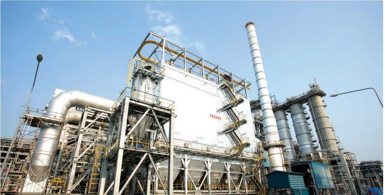
โรงงาน RDCC Unit 53 ติดตั้ง Electro Static Precipitator เพื่อเพิ่มประสิทธิภาพในการดักฝุ่นละออง
