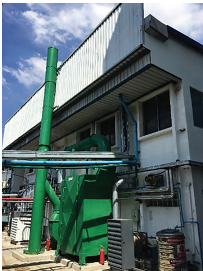
ปล่องระบายอากาศที่ติดตั้งระบบบำบัดอากาศแบบดูดซับด้วยถ่านกัมมันต์ (Activated Carbon)
