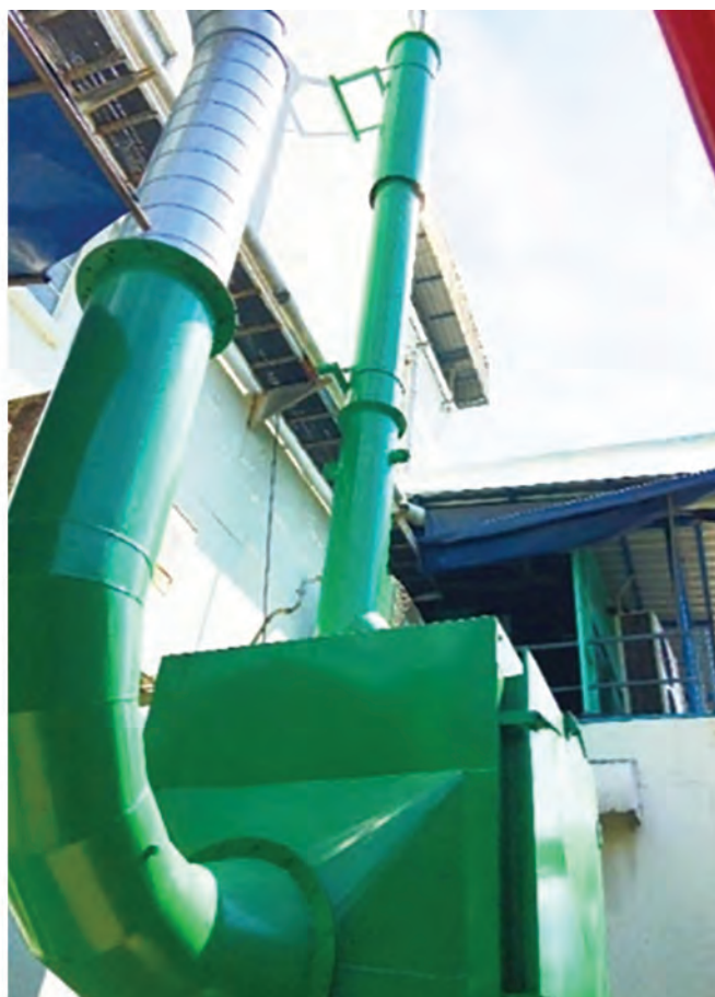
ปล่องระบายอากาศที่ติดตั้งระบบบำบัดอากาศแบบดูดซับด้วยถ่านกัมมันต์ (Activated Carbon)
