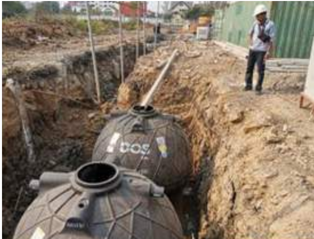
ภาพ : การติดตั้งบำบัดน้ำเสียสำเร็จรูปหรือระบบบำบัดน้ำเสียแบบบ่อคอนกรีต
