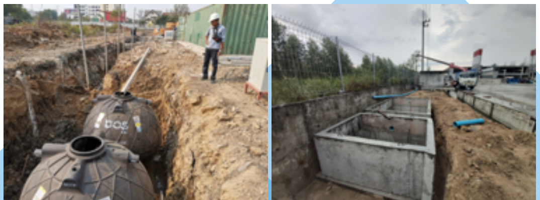
ภาพ : การติดตั้งถังบำบัดน้ำเสียสำเร็จรูปหรือระบบบำบัดน้ำเสียแบบบ่อคอนกรีต
