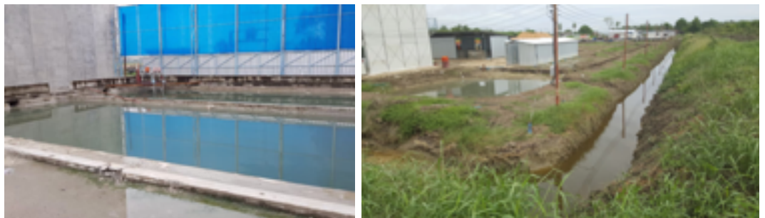
ภาพ : บ่อพักหรือรางดักตะกอน
