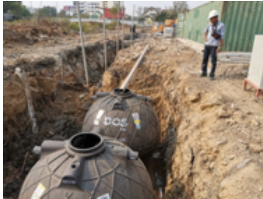
ภาพ : การติดตั้งถังบำบัดน้ำเสียสำเร็จรูป
