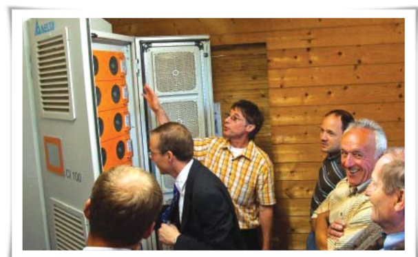
ผลิตภัณฑ์แปลงพลังงานสำหรับระบบพลังงานแสงอาทิตย์ รุ่น CI-100 ขนาด 100 กิโลวัตต์ที่ติดตั้งในคอกม้าที่เมือง Teningen ประเทศเยอรมัน
