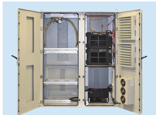
ตู้ควบคุมและจ่ายไฟฟ้าที่ใช้เซลล์เชื้อเพลิง ไฮโดรเจนในการเปลี่ยนพลังงานเป็นไฟกระแสตรง แรงดัน 42 โวลต์ สำหรับงานด้านโทรคมนาคม ที่ติดตั้งภายนอกอาคาร
