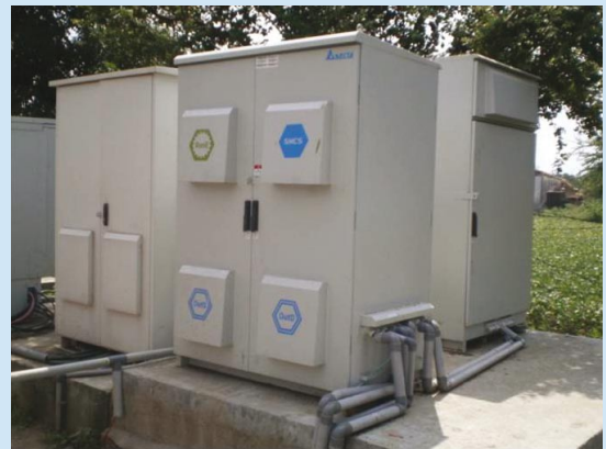
ระบบตรวจตราและควบคุมพื้นที่จากระยะไกลของเดลต้า ที่ติดตั้งในพื้นที่ติดตั้งอุปกรณ์โทรคมนาคมภายนอกอาคาร
