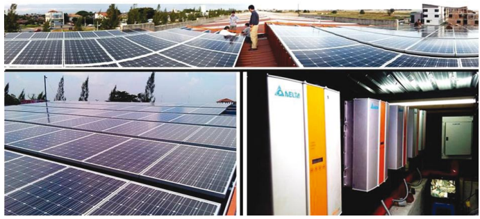
แผงพลังงานแสงอาทิตย์ขนาด 32 กิโลวัตต์และโซลาร์อินเวอร์เตอร์ Solivia 5.0 ที่ติดตั้งบนหลังคาร้านค้าในรัฐมะละกา ประเทศมาเลเซีย
