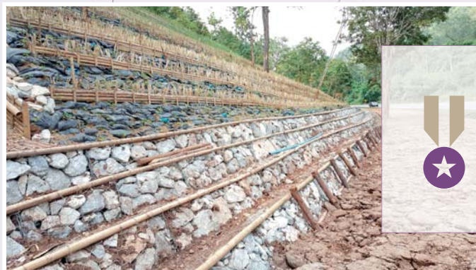
รูปแบบการใช้หญ้าแฝกในกระบอกไม้ไผ่ และการนำไปประยุกต์ใช้งานจริงในสนาม
