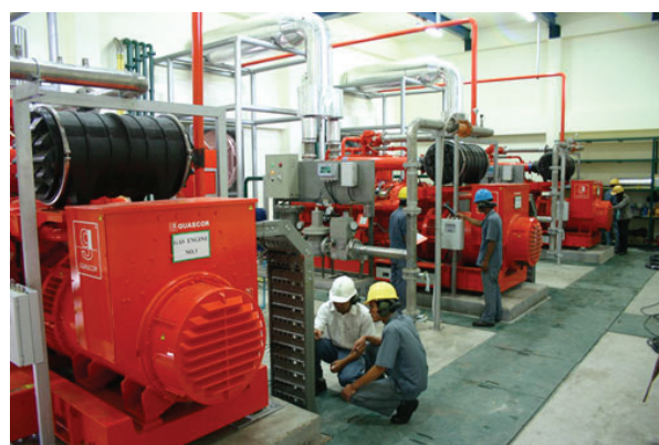
Three gas engine generators at the Topy CDM project เครื่องยนต์ผลิตกระแสไฟฟ้าจากก๊าซชีวภาพจำนวนสามเครื่องที่โรงงานไทยอุตสาหกรรม
