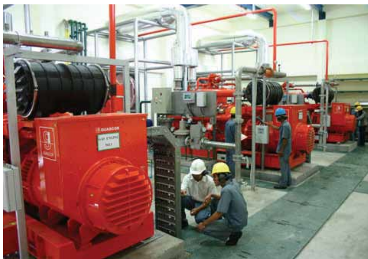
Three gas engine generators at the Univanich Topi CDM project เครื่องยนต์ผลิตกระแสไฟฟ้าจากก๊าซชีวภาพจำนวนสามเครื่องที่โรงงานไทยอุตสาหกรรม
