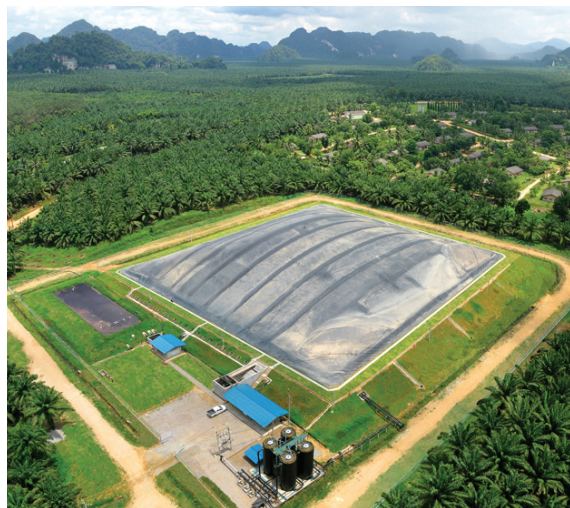
Methane capture from waste water at Topi Estate บ่อหมักก๊าซมีเทนที่สวนไทยอุตสาหกรรม
