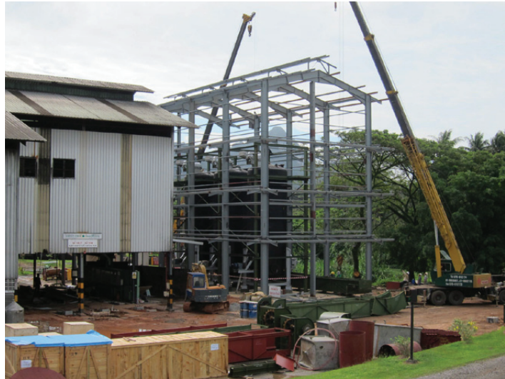
Contractors installed three vertical steam sterilizers manufactured in Malaysia ผู้รับเหมากำลังติดตั้งหม้อหนึ่งปาล์มแนวตั้ง 3 ลูก ซึ่งประกอบในประเทศมาเลเซีย
