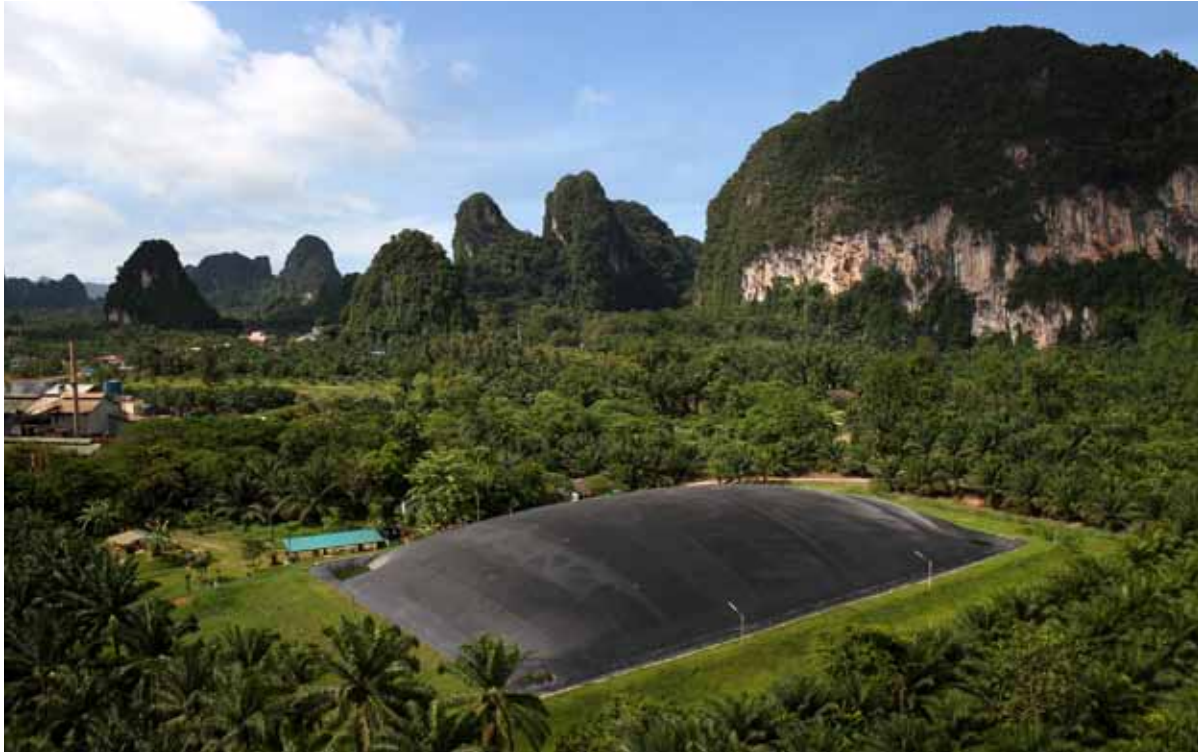
Biogas digester at Univanich Siam factory capturing greenhouse gases บ่อหมักก๊าซชีวภาพกักเก็บก๊าซเรือนกระจก
