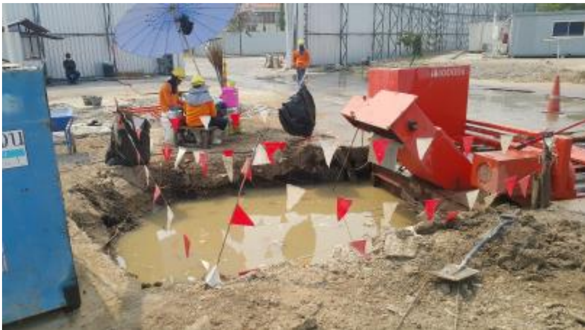
รูป 1.8 บ่อดักตะกอนข้างเครื่องล้างล้อ เพื่อรวบรวมตะกอนดินไม่ให้ไหลลงท่อน้ำสาธารณะ
