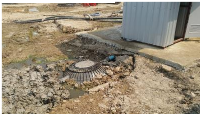
รูป 2.1 ถังบำบัดน้ำเสีย สำหรับห้องน้ำในโครงการ
