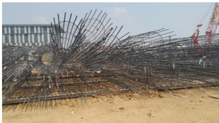
รูป 5.1 พื้นที่วางโครงเหล็ก มีแผ่นซีทไฟลร์รองเพื่อป้องกันโครงเหล็กสัมผัสกับดิน
