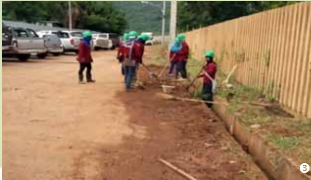
ตัวอย่างที่ 3 - คนงานก่อสร้างเคลียร์ที่ระบายน้ำและทำความสะอาดรอบๆ โครงการก่อสร้างเพื่อสิ่งแวดล้อมที่ดีและเพื่อให้สามารถระบายน้ำได้ดีขึ้น
