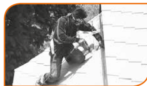
การติดตั้งหลังคาและโครงหลังคาในที่สูง
