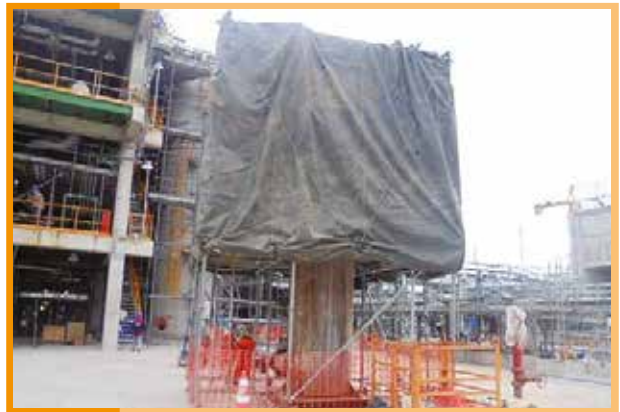
ภาพการติดตั้งอุปกรณ์ลดเสียงที่บริเวณปลายท่อ
