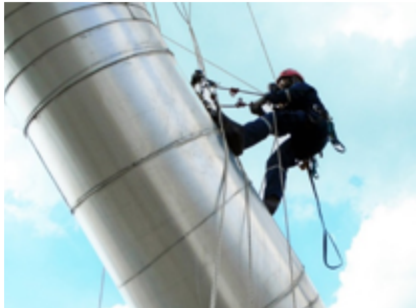
เทคนิคการไต่ตัวด้วยเชือกเพื่อการตรวจสอบและซ่อมบำรุง (Rope Access)
