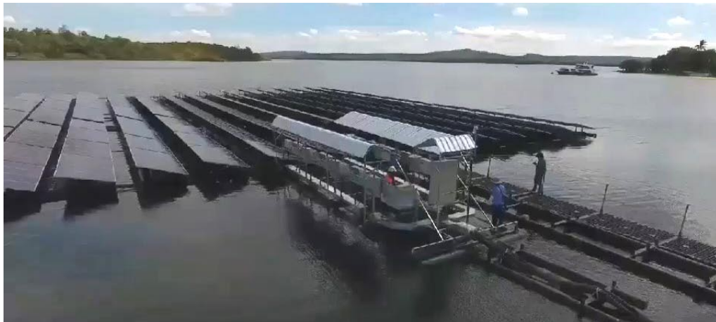
ภาพแสดงโครงการโรงไฟฟ้าพลังงานแสงอาทิตย์แบบติดตั้งบนน้ำ เชื้อนลรินธร ขนาด 256 กิโลวัตต์
