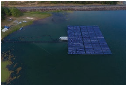
ภาพแสดงโครงการโรงไฟฟ้าพลังงานแสงอาทิตย์แบบติดตั้งบนน้ำ บริษัท ปราจีนบุรีกลาส อินดัสทรี จำกัด ขนาด 696.80 กิโลวัตต์
