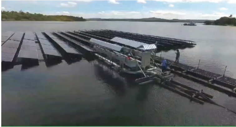
ภาพแสดงโครงการโรงไฟฟ้าพลังงานแสงอาทิตย์แบบติดตั้งบนน้ำ เชื้อนสิรินธร ขนาด 256 กิโลวัตต์
