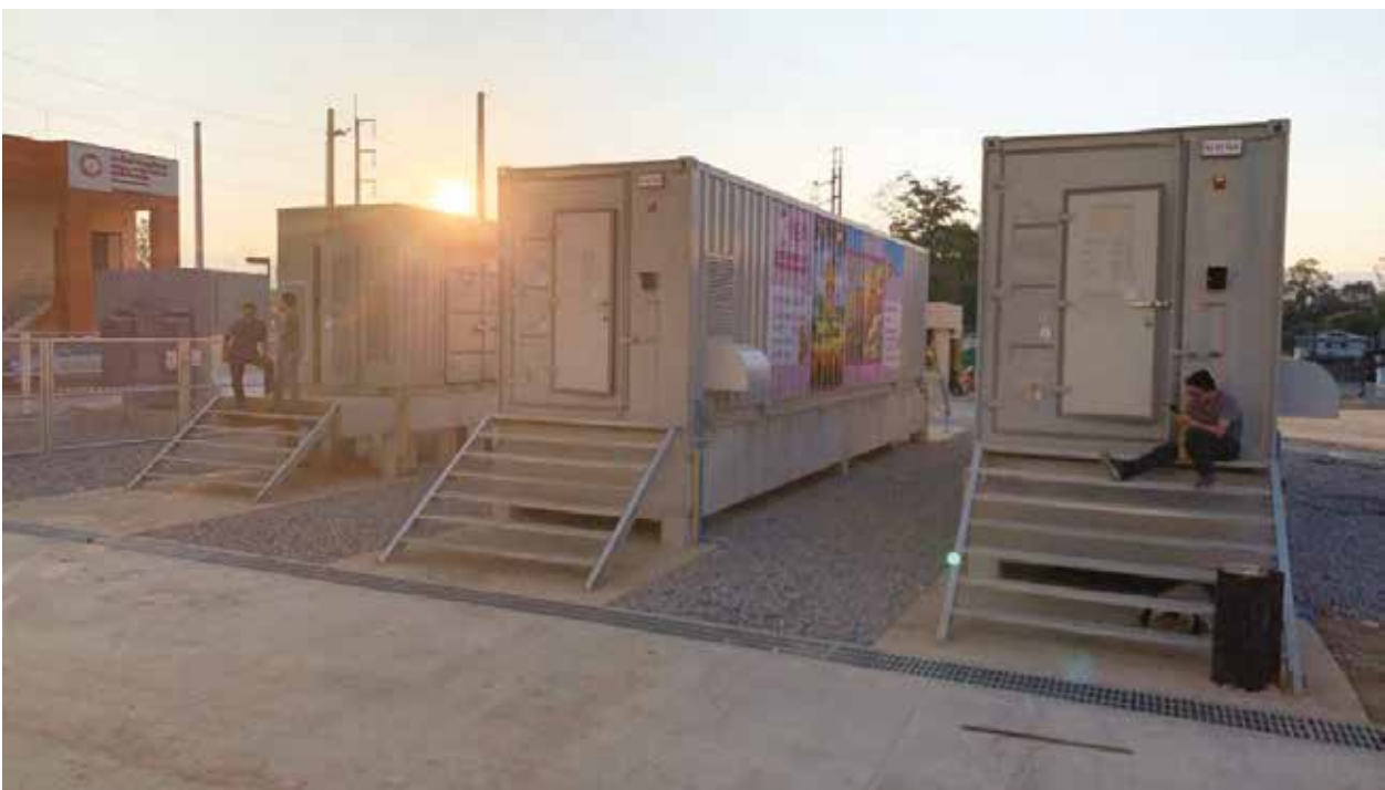
ภาพแสดงอุปกรณ์กักเก็บพลังงาน (Battery Energy Storage system) ขนาด 3MW/2.2 MWh โครงการพัฒนาระบบไฟฟ้าแบบโครงข่ายไฟฟ้าขนาดเล็กมาก (microgrid) ที่ อ.แม่สะเรียง จ.แม่ฮ่องสอน ของการไฟฟ้าส่วนภูมิภาค
