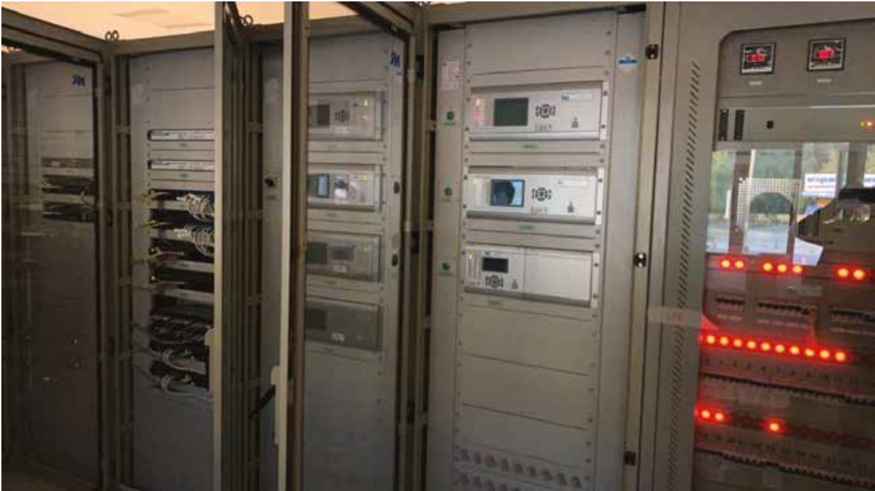
ภาพแสดงอุปกรณ์ระบบไฟฟ้าอัจฉริยะ (Microgrid controller) โครงการพัฒนาระบบไฟฟ้าแบบโครงข่ายไฟฟ้าขนาดเล็กมาก (microgrid) อ.แม่สะเรียง จ.แม่ฮ่องสอน ของการไฟฟ้าส่วนภูมิภาค (2)
