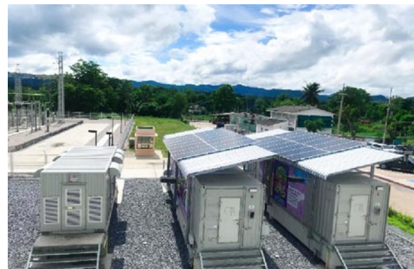
ภาพแสดงอุปกรณ์ควบคุมระบบไฟฟ้าอัจฉริยะ (Microgrid controller) โครงการพัฒนาระบบไฟฟ้าแบบโครงข่ายไฟฟ้าขนาดเล็กมาก (microgrid) อ.แม่สะเรียง จ.แม่ฮ่องสอน ของการไฟฟ้าส่วนภูมิภาค
