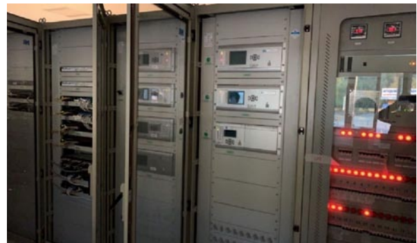
ภาพแสดงอุปกรณ์ควบคุมระบบไฟฟ้าอัจฉริยะ (Microgrid controller) โครงการพัฒนาระบบไฟฟ้าแบบโครงข่ายไฟฟ้าขนาดเล็กมาก (microgrid) อ.แม่สะเรียง จ.แม่ฮ่องสอน ของการไฟฟ้าส่วนภูมิภาค
