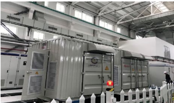
ภาพแสดงอุปกรณ์ควบคุมระบบไฟฟ้าอัจฉริยะ (Microgrid controller) โครงการพัฒนาระบบไฟฟ้าแบบโครงข่ายไฟฟ้าขนาดเล็กมาก (microgrid) อ.แม่สะเรียง จ.แม่ฮ่องสอน ของการไฟฟ้าส่วนภูมิภาค
