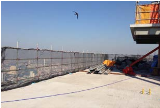
ภาพตัวอย่าง แผงโครงเหล็กตาข่ายที่ใช้เพื่อป้องกันเศษวัสดุก่อสร้างร่วงใส่พื้นที่บริเวณรอบๆ อาคารมหานคร ทาวเวอร์
