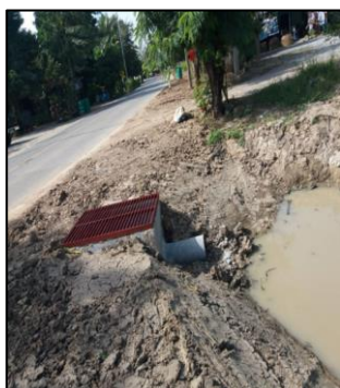
โครงการฝังท่อระบายน้ำพร้อมบ่อพักที่บ้านสระบัวก่ำ หมู่ที่ 7 ระยะทาง 138 เมตร เป็นเงิน 369,000.- บาท เพื่อช่วยเหลือชุมชน ให้สามารถระบายน้ำออกสู่ภายนอกได้สะดวก ป้องกันน้ำท่วมขังในหมู่บ้านในฤดูฝน ตามโครงการ “ความร่วมมือเพื่อการพัฒนาชุมชน สังคม และสิ่งแวดล้อมอย่างยั่งยืน” ประจำปี 2561
