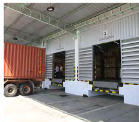
ประตูสำหรับขนถ่ายสินค้าและลานยกกระดานไฮดรอลิก (Overhead Doors With Hydraulic Dock Levelers)
