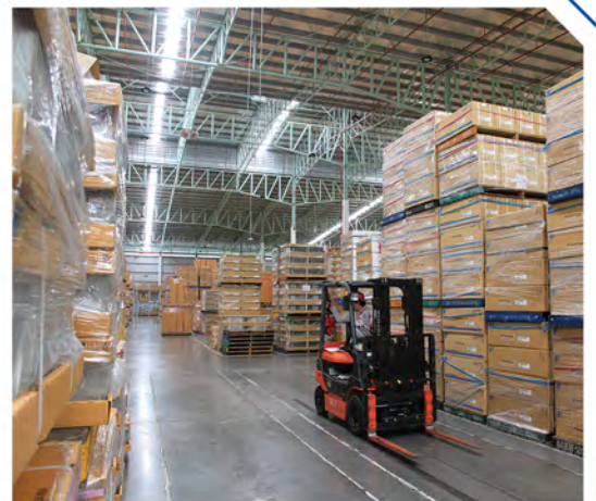
พื้นคอนกรีตคุณภาพสูง รับน้ำหนักได้ 3-5 ตัน (Industrial Concrete Floor)
