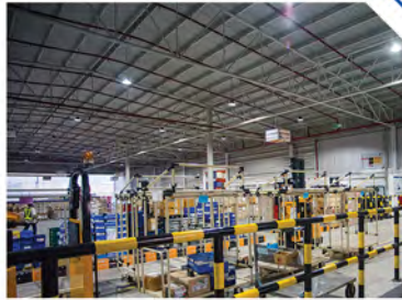
โครงสร้างอาคารเหล็ก (Pre-Engineered Steel Structure)
