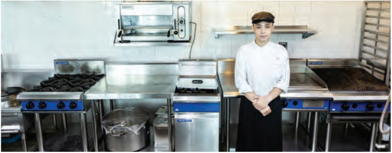
จำหน่ายและติดตั้งชุดครัวประกอบอาหารในครัวโรงแรม
