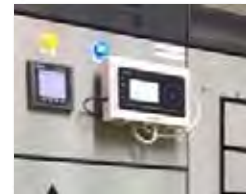
4. อุปกรณ์ควบคุมตู้สวิตช์บอร์ด และอุปกรณ์แสดงผล
