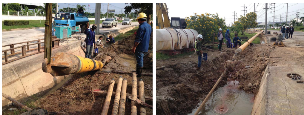
การขุดเจาะแบบไม่เปิดหน้าดิน (HDD)
