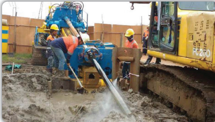
การเจาะดิ่งท้อลอด (HDD)
