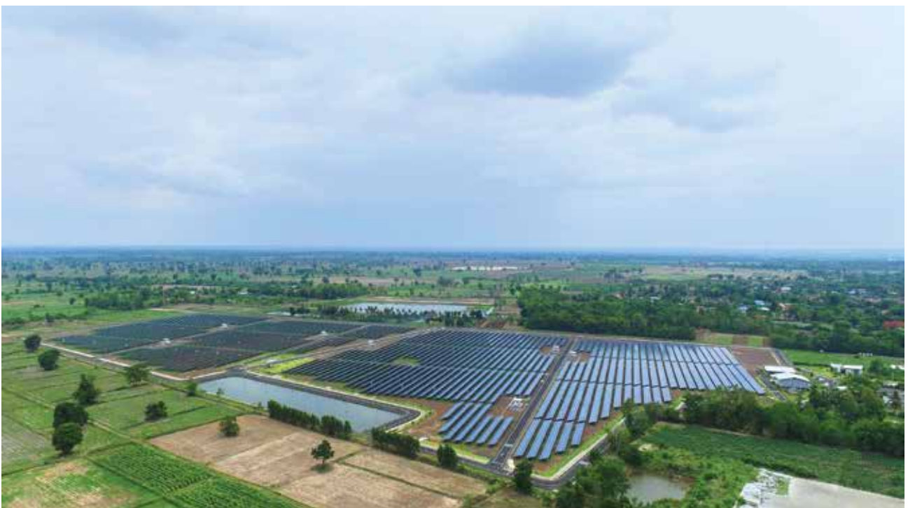
โรงไฟฟ้าพลังงานแสงอาทิตย์ หนองกี่ จังหวัดบุรีรัมย์ ประเทศไทย (8 MW PPA )
