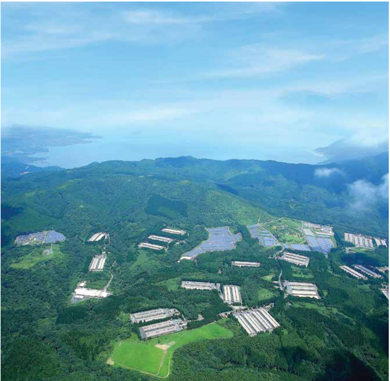
โรงไฟฟ้าพลังงานแสงอาทิตย์ Tarumizu ประเทศญี่ปุ่น (8.1 MW PPA )
