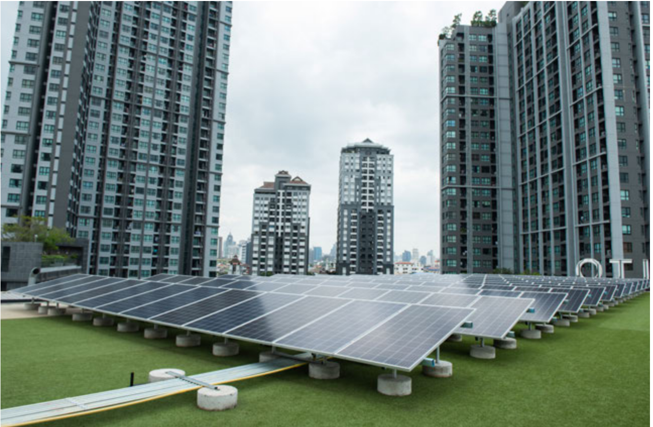
โครงการติดตั้งโซลาร์รูฟท็อปในโครงการ T77
