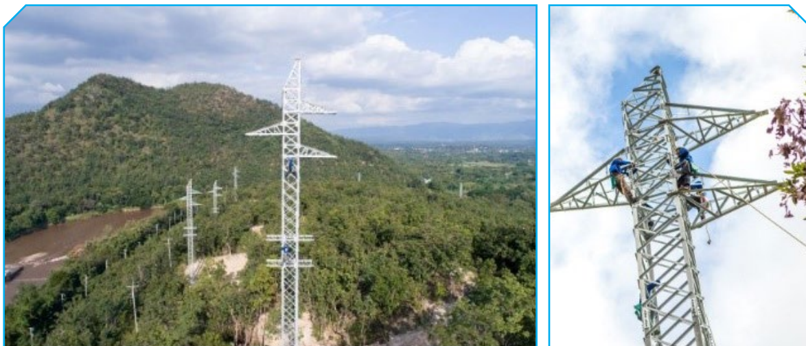
ระบบสายส่งไฟฟ้าแรงสูง 115 kV ที่อยู่ระหว่างติดตั้ง
