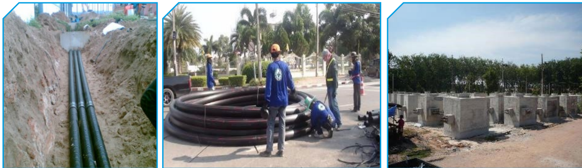
ระบบสายส่งไฟฟ้าและระบบจำหน่ายไฟฟ้าใต้ดิน
