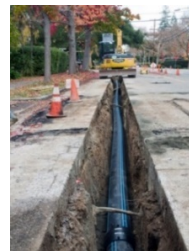
ภาพตัวอย่างท่อ HDPE (ซ้าย) และตัวอย่างการใช้งานจริง (ขวา)
