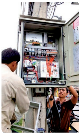
การติดตั้งและวางระบบ FRTU
