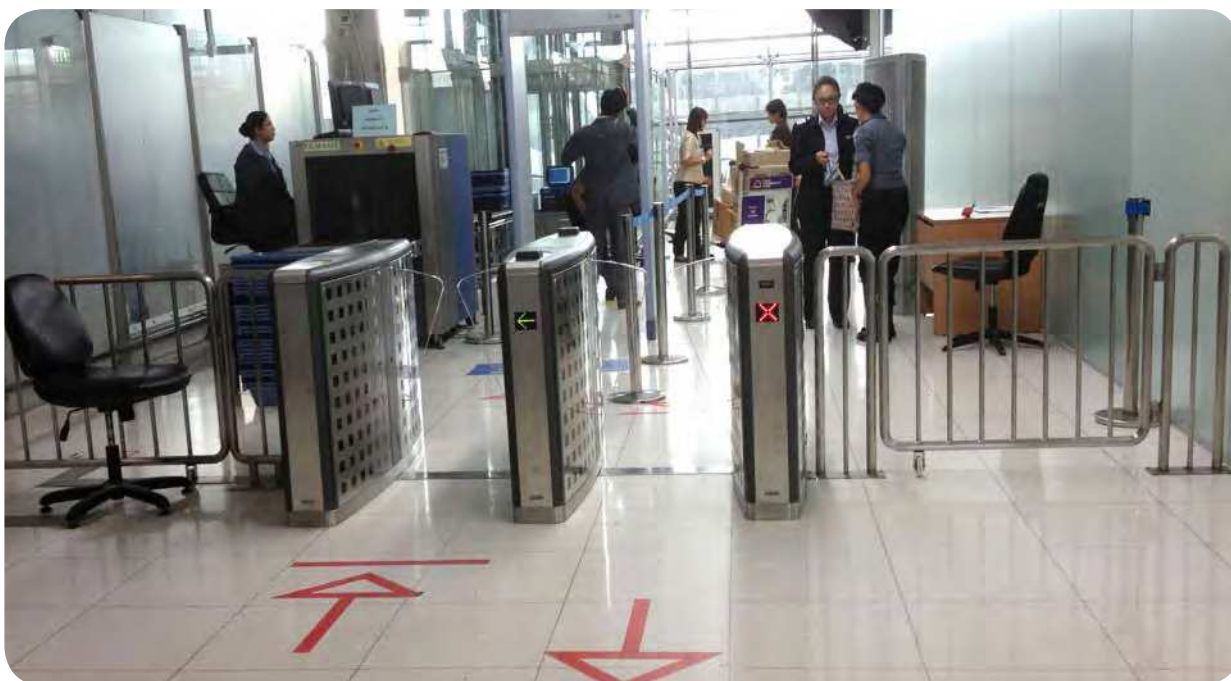
ระบบควบคุมการผ่านเข้า-ออกพื้นที่หวงห้ามท่าอากาศยานสุวรรณภูมิ ที่ติดตั้งเครื่องอ่านบัตรรักษาความปลอดภัย
