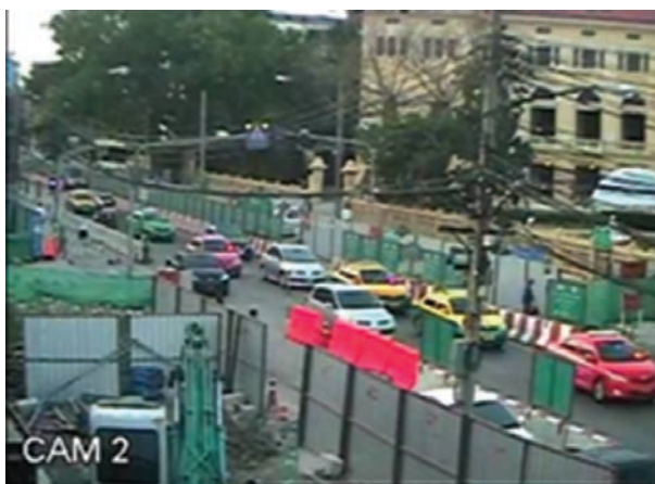
ภาพการใช้กล้องวงจรปิดเพื่อติดตามสำรวจปริมาณการจราจรบนถนนสนามไชย โครงการก่อสร้างรถไฟฟ้าสายสีน้ำเงิน
