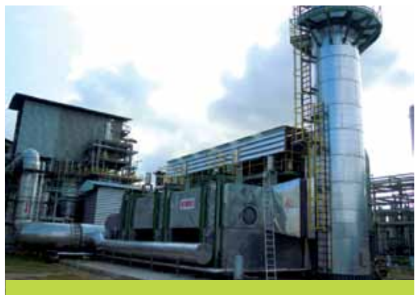
ติดตั้งเครื่องกำจัดกลิ่นหน่วยที่ 2 เพิ่มเสถียรภาพการดำเนินงานที่ลดผลกระทบต่อสิ่งแวดล้อม
