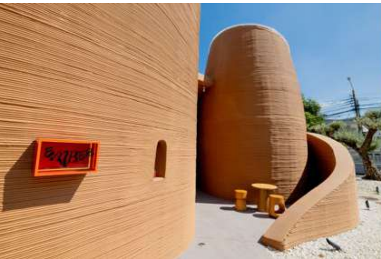
Ember Cafe วัสดุ 9 ชอย 43 โดดเด่นด้วยดีไซน์ ออกแบบเส้นสายความโค้งอย่างเป็นอิสระสวยงาม ด้วยนวัตกรรม SCG 3D Printing
