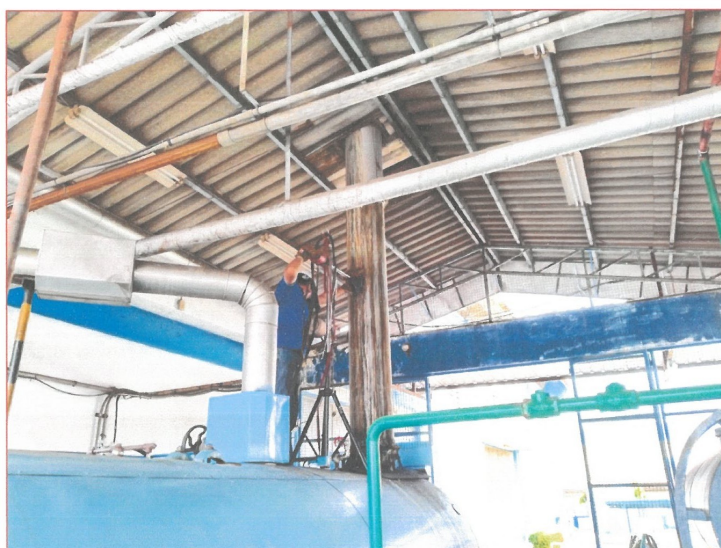
รูปที่ 1 การตรวจวัด Total Suspended Particulate, Sulfur dioxide, Carbon monoxide และ Oxides of Nitrogen บริเวณ ปล่อง Boiler
