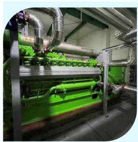
ติดตั้งระบบสายส่งไฟฟ้าจากไบโอมแก๊สมาใช้งานกระบวนการผลิต
