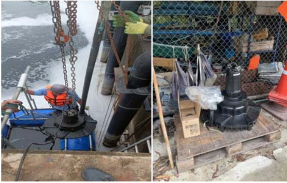
4. งานเปลี่ยน submersible pump ที่ป้อมปรับสมดุล
