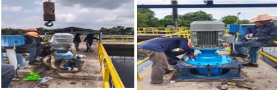
5. งานเปลี่ยน Surface Aerator ที่ป้อมเติมอากาศ มอเตอร์ Surface Innomoticsc และ มอเตอร์ Surface SIEMENS kW
