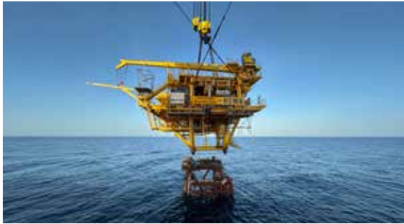
การเคลื่อนย้ายส่วนบนของแท่นหลุมผลิตปิโตรเลียมกลับมาใช้ใหม่
