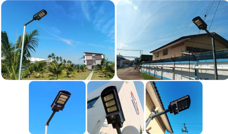
การปรับปรุงไฟฟ้าส่องสว่างภายในบริเวณโรงงานเพิ่มเติม โดยใช้ Spotlight Solar Cell
