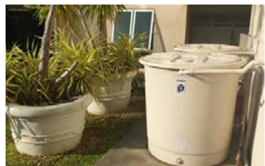
ถังเก็บน้ำจากการกลั่นตัว จากระบบปรับอากาศหลัก (Chiller Plant) ภายในอาคาร
