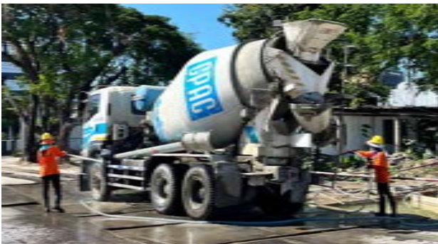
ล้างล้อรถที่เข้าโครงการ เพื่อป้องกันเศษดินติดล้อรถออกสู่ถนน
