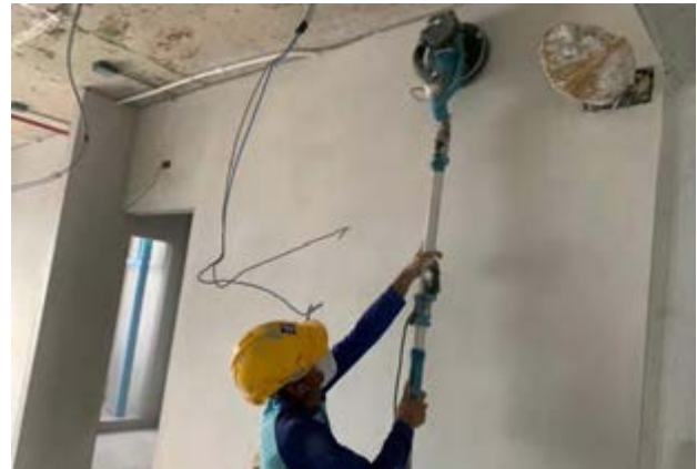
ใช้เครื่องขัดผิวที่สามารถดูดฝุ่นได้ เพื่อลดฝุ่นและลดมลพิษที่เกิดจากงานสถาปัตยกรรม
