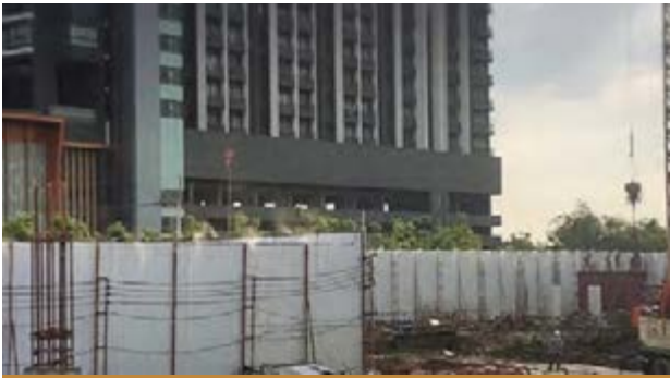
รั้วรอบโครงการสูง 6 เมตร และติดตั้งสเปรย์น้ำรั้วชั่วคราวรอบโครงการ เพื่อป้องกันเสียงและฝุ่น
