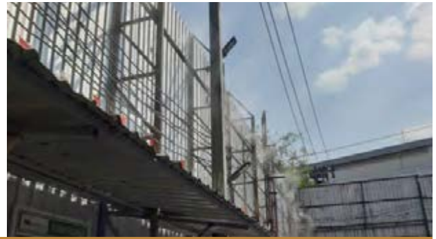
รั้วรอบโครงการสูง 6 เมตร และติดตั้งสเปรย์น้ำรั้วชั่วคราวรอบโครงการ เพื่อป้องกันเสียงและฝุ่น
