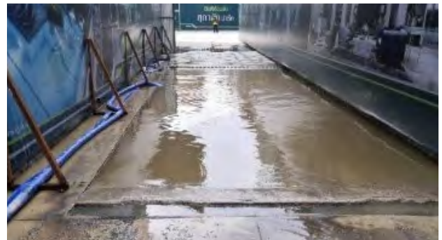
ล้างล้อรถที่เข้าโครงการ เพื่อป้องกันเศษดินติดล้อรถออกสู่ถนน
